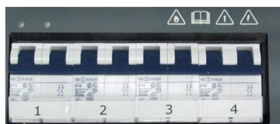
Le système 12 Volt comprend principalement les circuits électriques protégés sur le Panel 301 ; veuillez consulter les manuels livrés séparément pour ces panneaux. Le présent mode d'emploi traite systématiquement de la commande. Le panneau 12 Volt est facile à ouvrir en tournant les deux vis du bord droit du panneau ; le panneau s'ouvre alors aisément.
